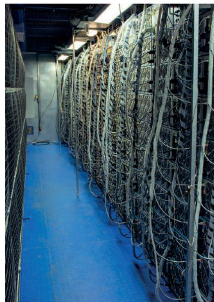
▲ Рис. 2. Высоконагруженные стойки с ИТ-оборудованием, охлаждаемые с помощью прямой подачи наружного воздуха
