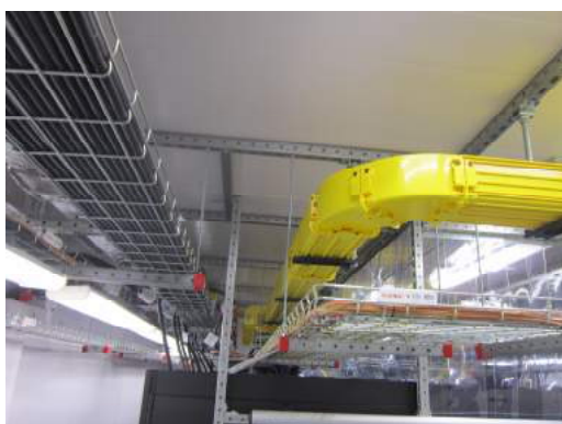
Рис 3. Система лотков и коробов как должно быть.
