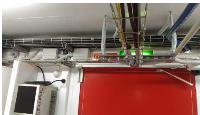
Рис 3. Система лотков и коробов как должно быть.
