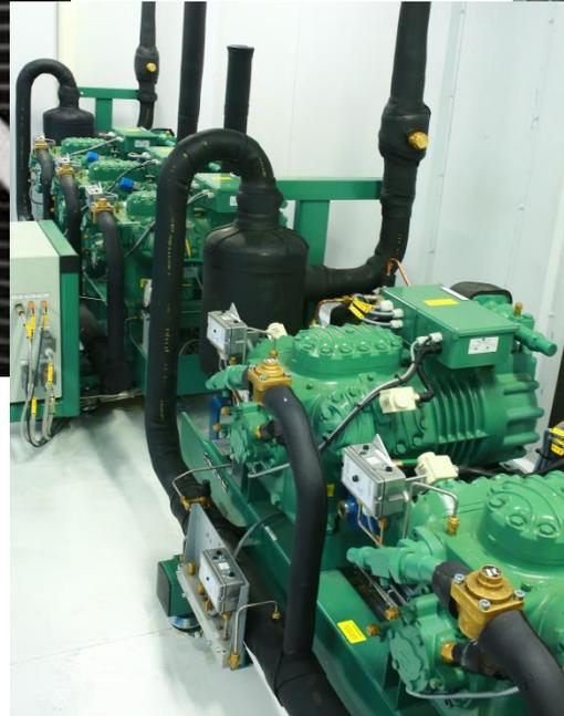
Для работы в жаркие часы летних дней предусмотрены фреоновые холодильные машины на полную производительность. Они же обеспечивают резерв на время обслуживания ротора.
