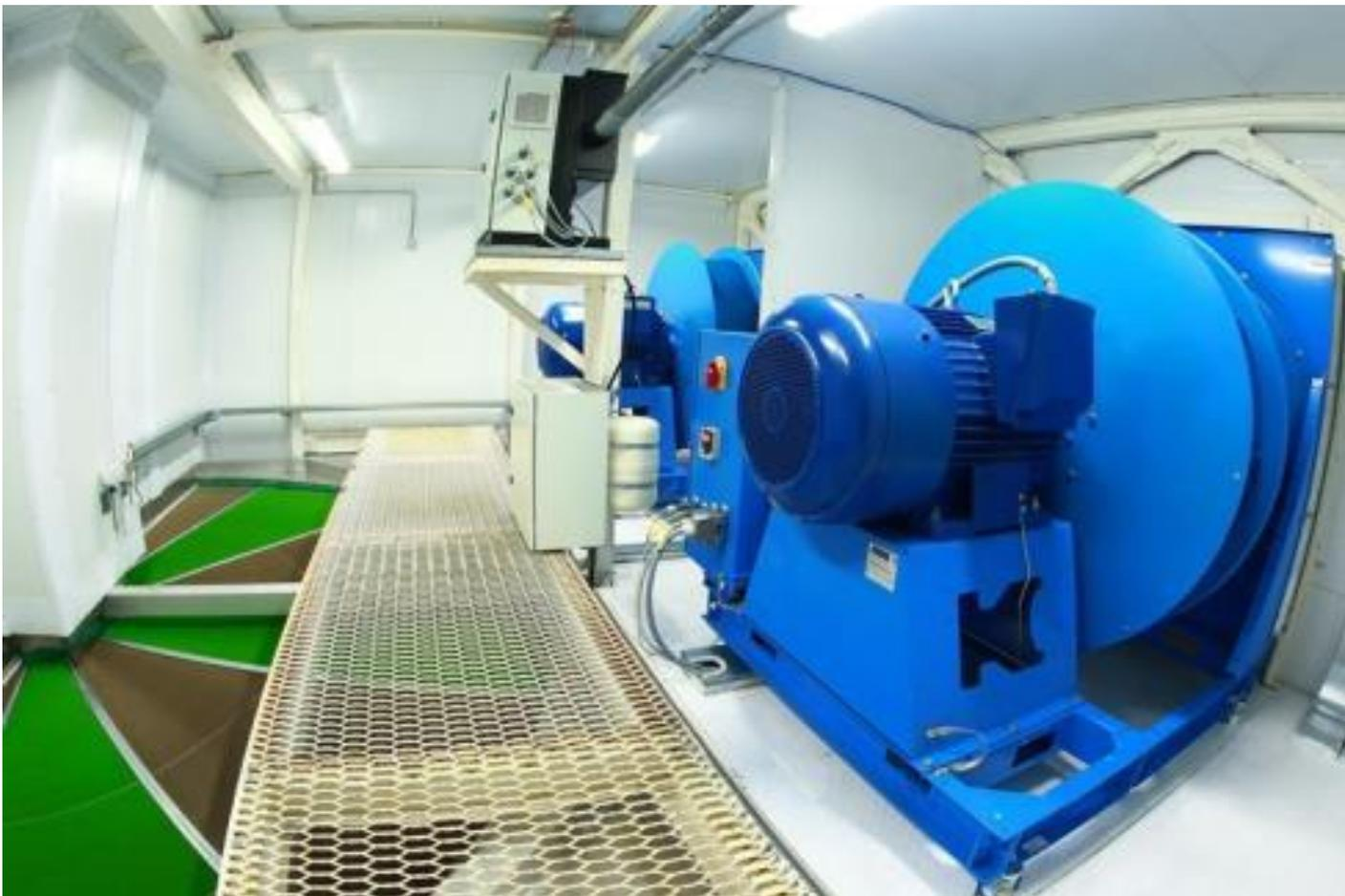
Циркуляцию воздуха обеспечивают мощные промышленные вентиляторы с частотным регулированием скорости вращения. В серверном зале имеются датчики перепада давления между холодным и горячим коридорами для оптимального управления производительностью.
