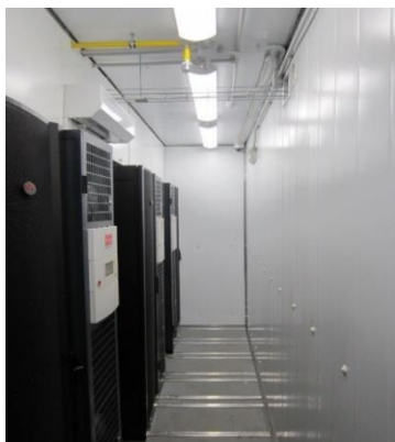
Внутренняя отделка и монтаж инженерных систем
